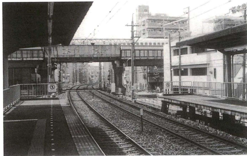
下新庄駅より淡路方向を見る。新設の高架は前方に見える新幹線高架を跨ぐことになる。 2011.04.26 撮影
