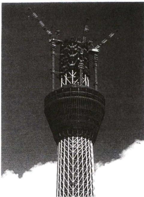
写真はタワークレーンが設置された初期段階で、この後、スカイツリー本体と一緒に伸びて行きました。このクレーンは自身の力で上部にマスト(クレーンを支える)を継足し、その伸びた部分をクレーン部分が登って行きました。(マストクライミング方式)使用が終わると今度は逆の手順でマストを自力で撤去し、第一展望台まで降りてきます。そこからは次に示す手順となります。(Step1~5)
