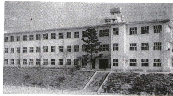
完成した鉄筋校舎(第一期)の全景
