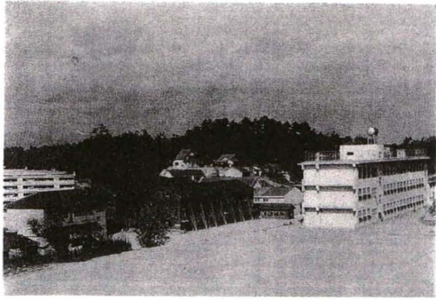
校舎全景 (昭和32年) 鉄筋講堂並びに第一期3階建新校舎と新運動場完成
