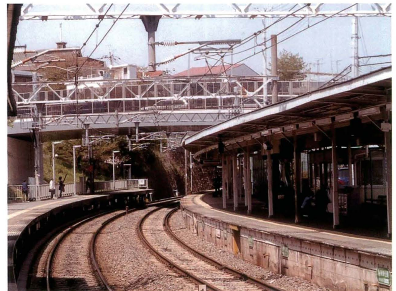
千里山駅跨線橋
