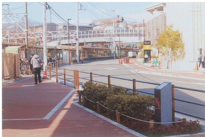
1. 旧文化路切（現在車両通行禁止）手前より横断跨線橋を望む
