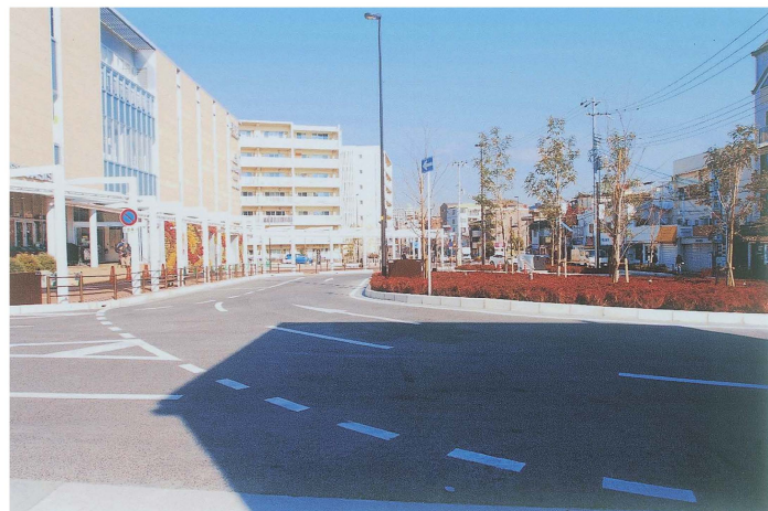
2. 駅側から広場を見る
